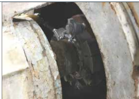
442Cカートリッジ型スプリット・シール114 mm (4.50") は2時間以内で取付けが完了しました。
